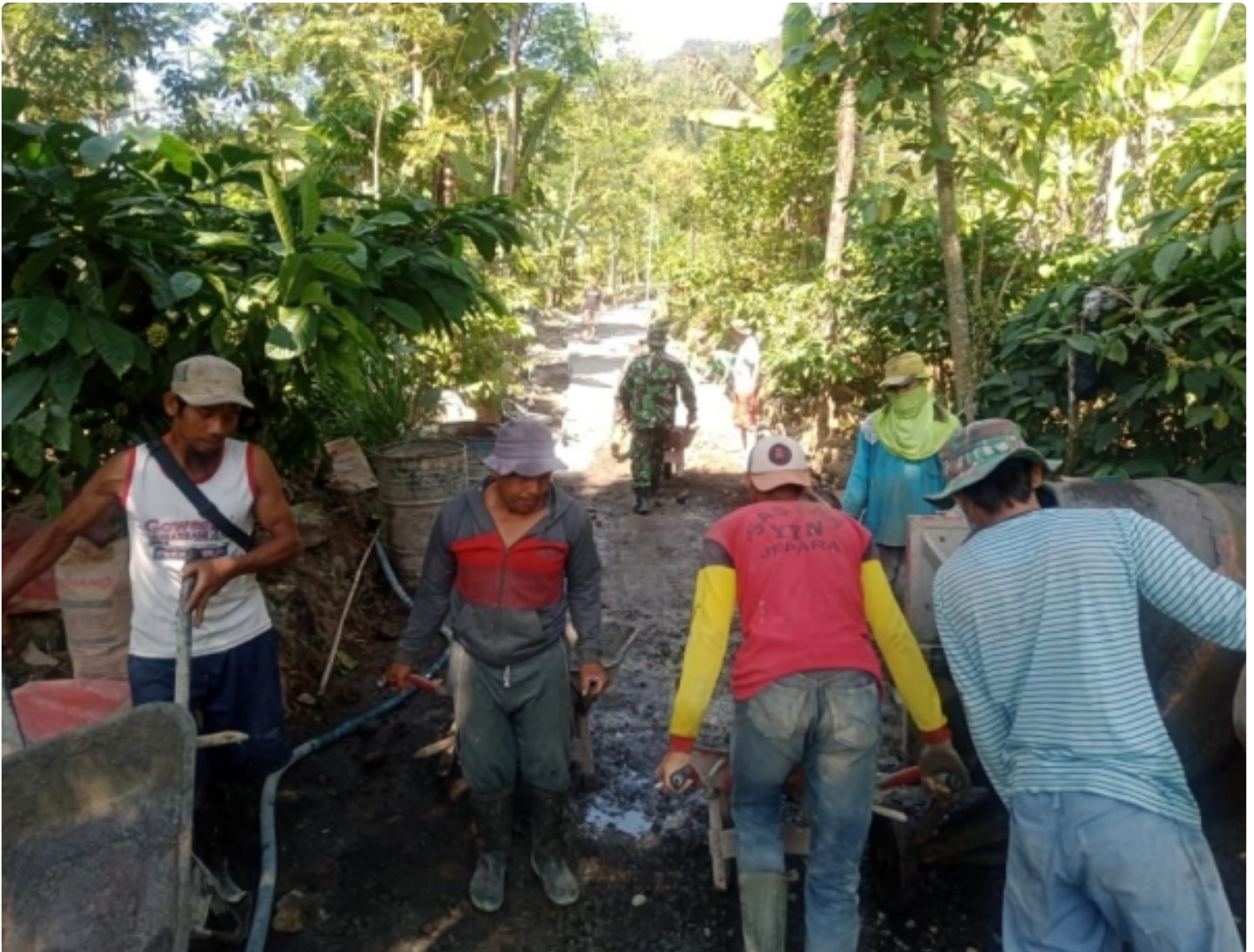
Warga Desa Tempur bergotong-royong pengecoran jalan menuju candi angin
